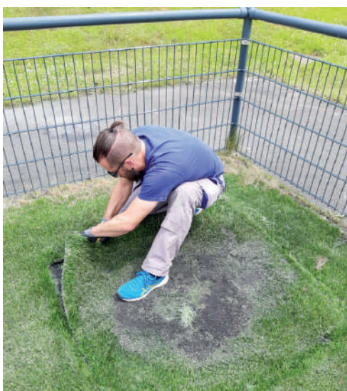
RÉPARATION D'UN TERRAIN SYNTHÉTIQUE
